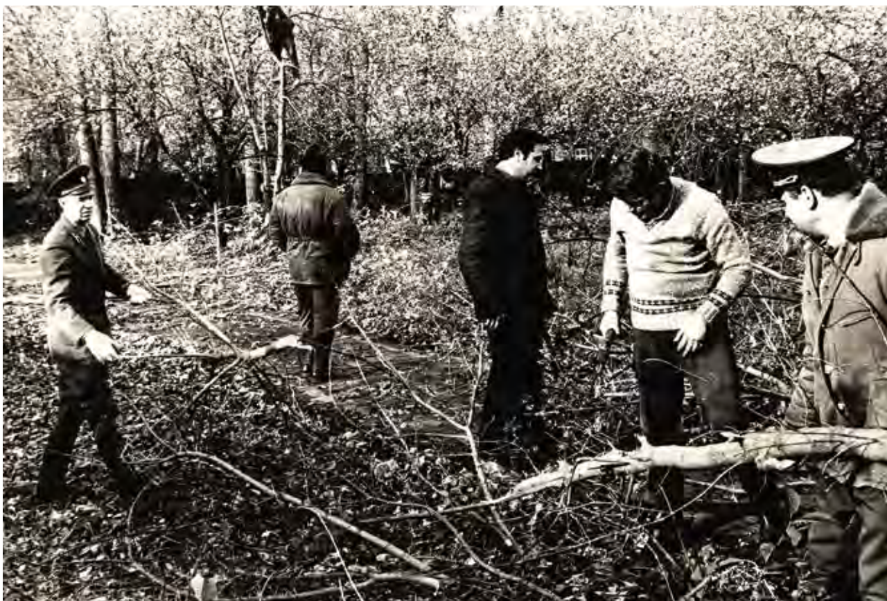
Расчистка площадки под строительство учебной башни ПЧ-4. Соколов Н.П. — второй справа
