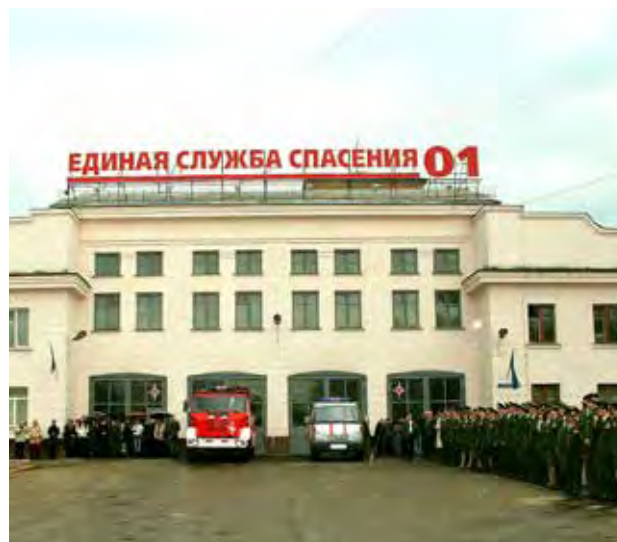
Фасад 4 пожарной части 28.04.2007
