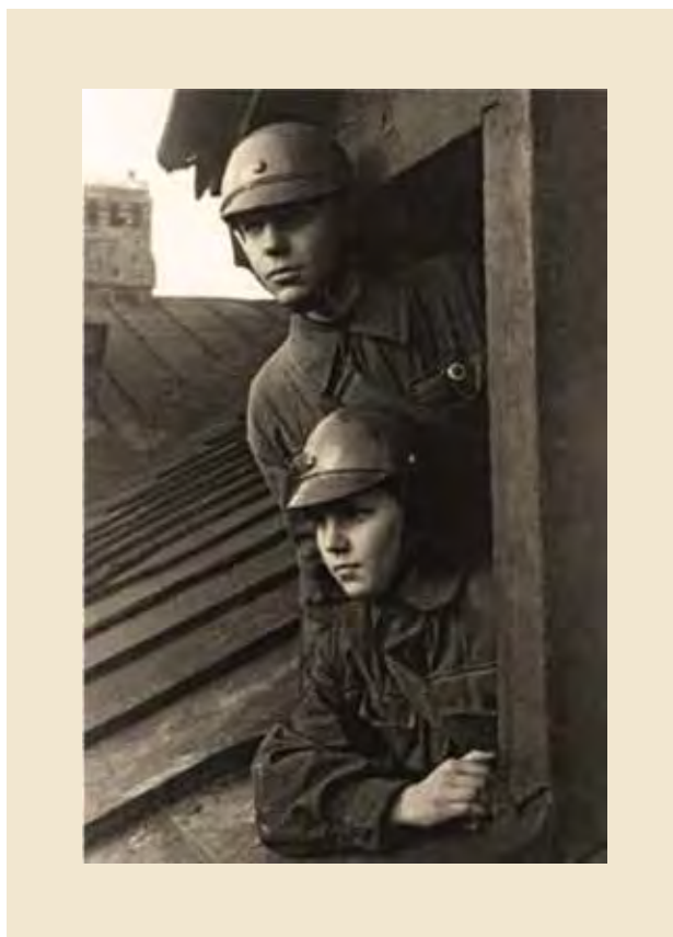
На противопожарном посту
