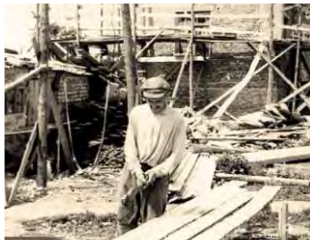
Начало строительства здания ПЧ-29 (ранее до 1983 года ПЧ-39). 1961 год
