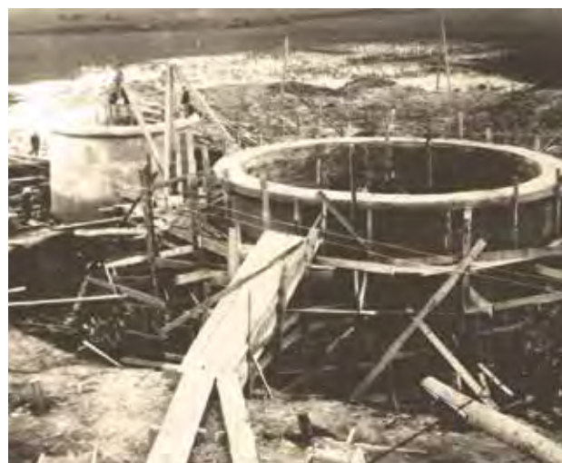
Строительство южной насосной станции. 1933 г.
