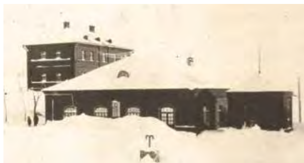
Рогожинская водочкачка, начало XX в.
