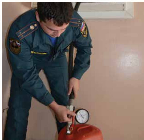
Испытание кранов внутреннего противопожарного водопровода стволом-водомером HPS
