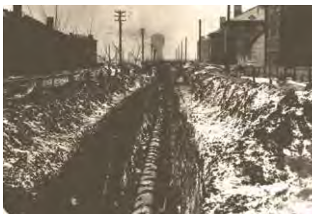
Прокладка тульского водопровода
