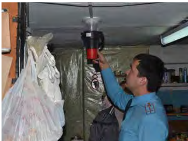
Проверка дымовых извещателей автоматической установки пожарной сигнализации
