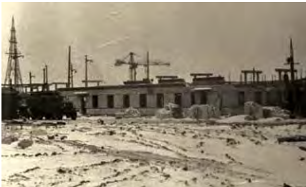
Строительство пожарных частей, ставших основой для создания 1 отряда военизированной пожарной охраны Новомосковского химкомбината
