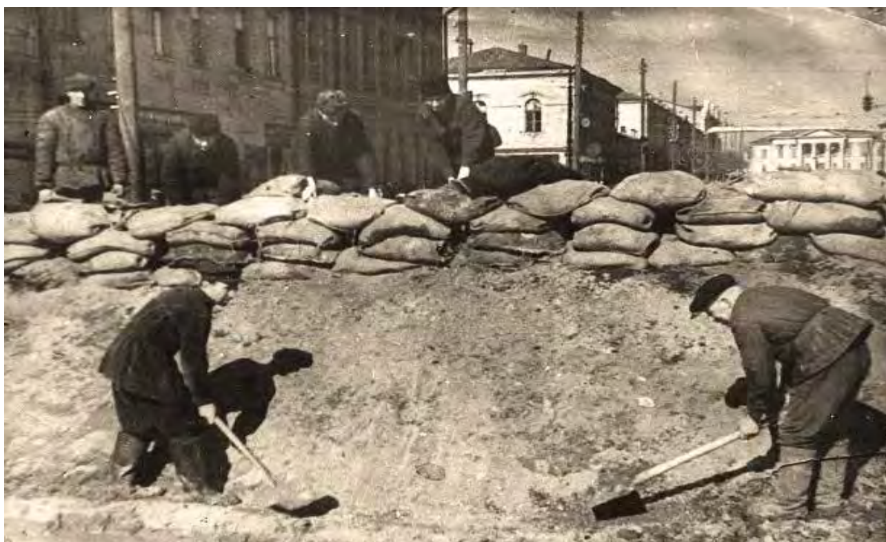
Сооружение укреплений на городских улицах. Тула. 1941 г.
