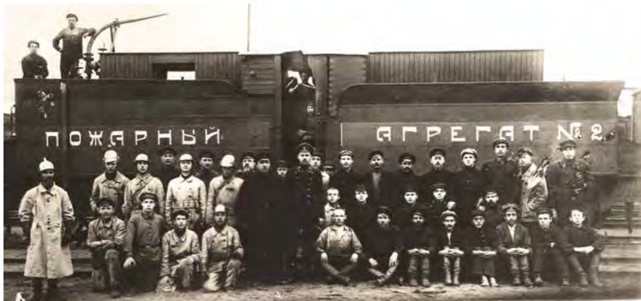
1925 год. Пожарный агрегат для тушения пожара на железной дороге. Ст. Узловая
