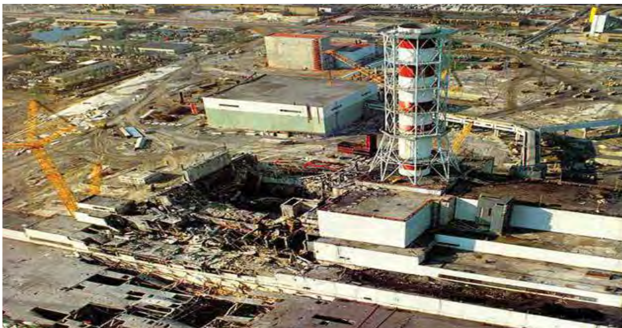
Разрушенный 4-й энергоблок
